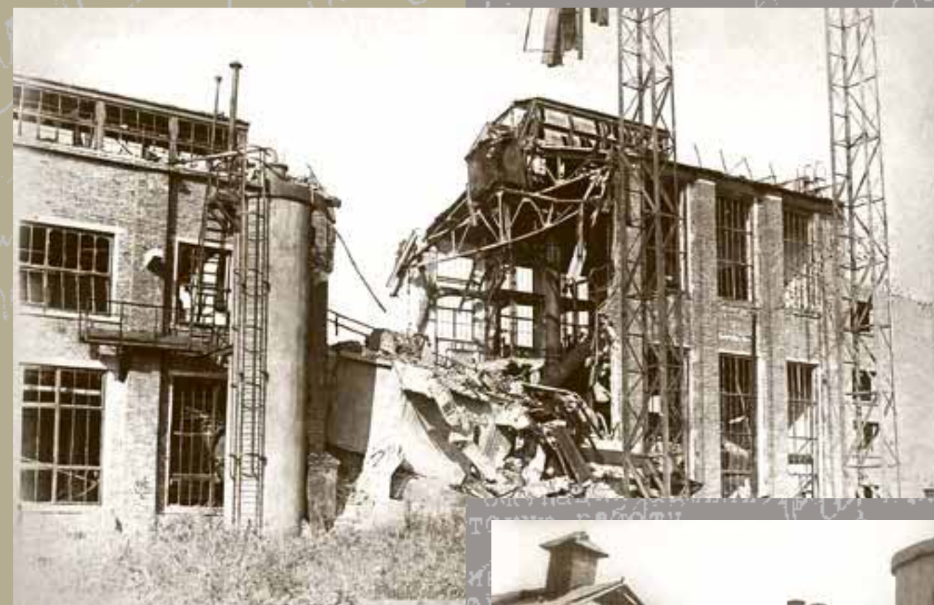
▲ Здание газостанции. ТГЛИАМЗ
