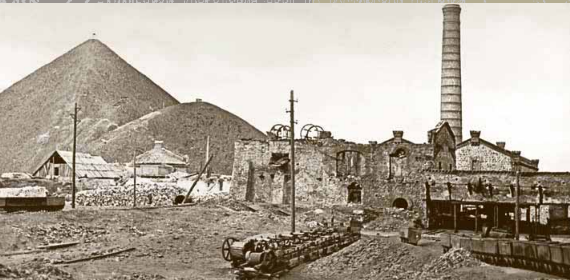
▲ Шахтный двор. Шахта им. Петровского, г. Шахты. ЦДНИРО ► Надшахтное здание. Шахта им. Артема, г. Шахты. ЦДНИРО ▼ Шахта им. «Комсомольской правды». Взорванный барабан подъемной машины. ЦДНИРО
